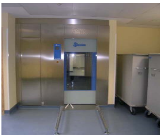
Figuras 4 y 5. Túnel de lavado y desinfección automatizada para el procesamiento de carros y material de gran volumen.
