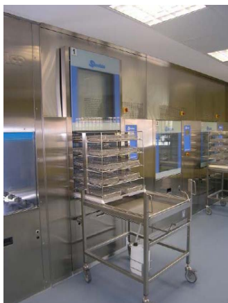
Figura 6. Carga de bandejas de la lavadora automática.
