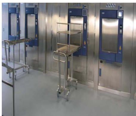
Figura 9. Barrera de autoclaves de doble puerta de vapor con carga desde la zona de preparación y empaquetado.
