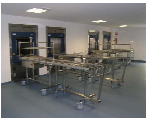
Figura 11. Autoclaves de vapor de doble puerta, desde la zona de almacén de material estéril, con sistema de descarga automática.
