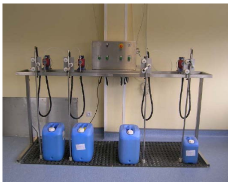
Figura 1. Central dosificadora de detergentes sobre foso de seguridad, para la alimentación de lavadoras automatizadas.
