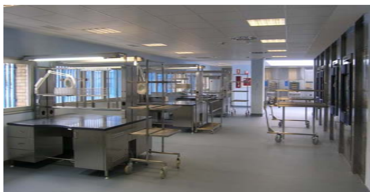
Figura 7. Zona de preparación, empaquetado y esterilización, con estaciones de trabajo. A la derecha, los esterilizadores, con espacio para la carga.
