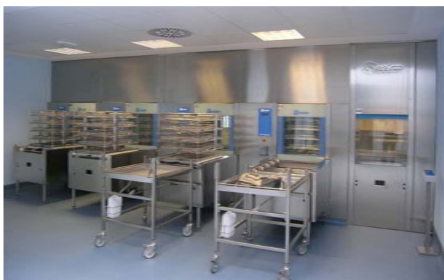
Figura 8. Barrera de lavadoras, vista desde la zona de preparación y empaquetado. Plataformas de descarga asociadas a la salida de las lavadoras.
