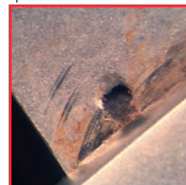
Ejemplo de corrosión de picadura
